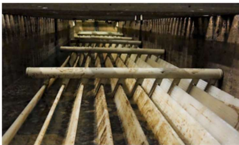
Abbildung 19: Kühlung durch schwimmende Kühlrippen im Güllekanal (Bildquelle: L. Wokel, Uni Hohenheim)
