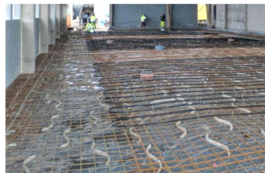
Abbildung 18: Verlegung von Kühlrohren bzw. Kühlschlangen im Boden des Güllekellers (Bildquelle: Ingenieurbüro Honsa GbR)
